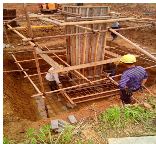
南琴线 27#塔基施工
