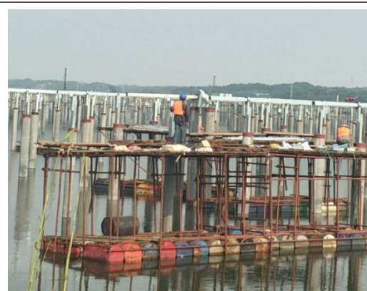
光伏区支架安装
