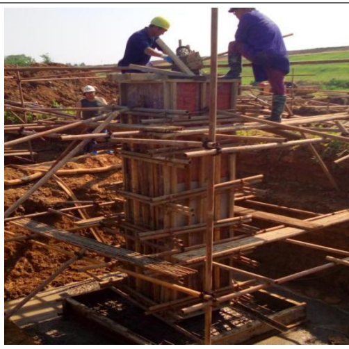
南琴线 27#塔基基础浇筑
