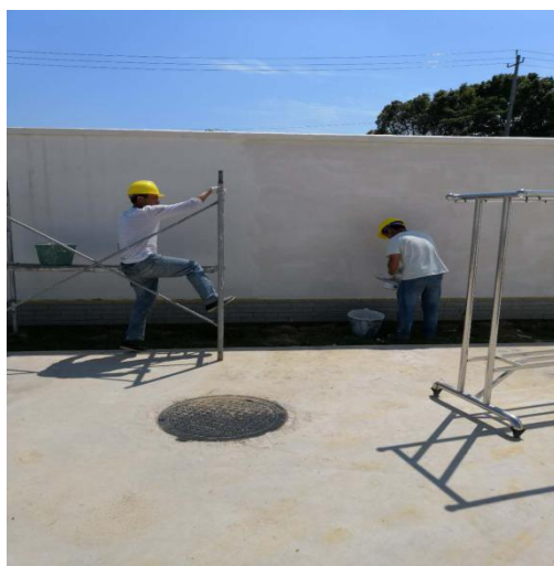
开关站围墙消缺
