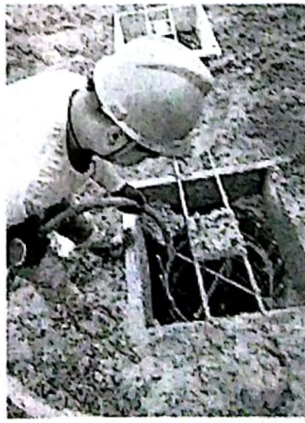
基础浇筑旁站
