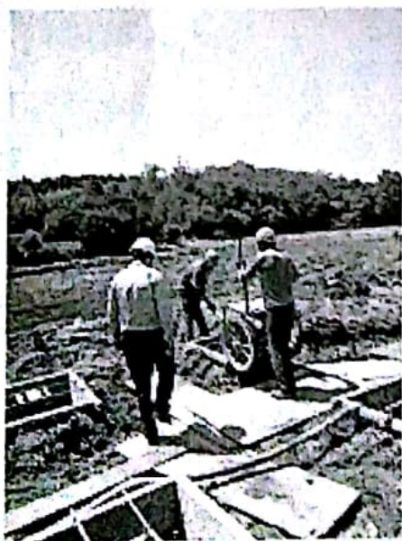
基础浇筑旁站
