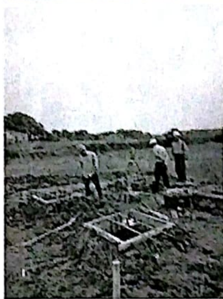
基础浇筑前检查
