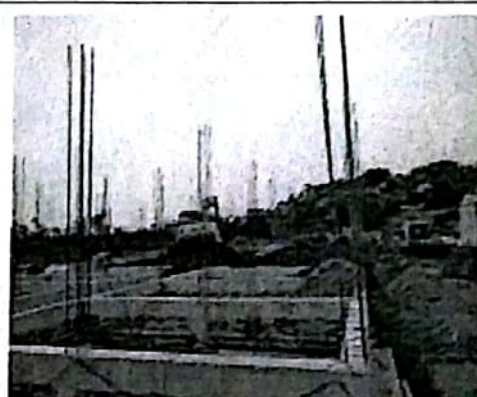
办公综合楼基础土方回填
