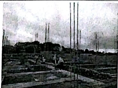
配电综合楼电缆沟钢筋绑扎
