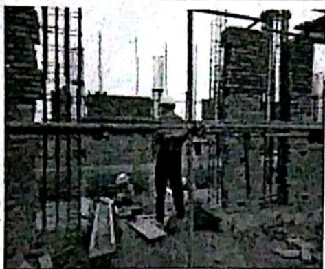
配电综合楼电缆沟钢筋绑扎
