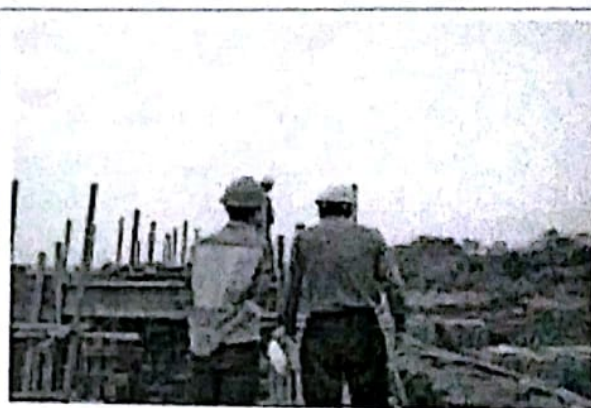
设备基础浇筑
