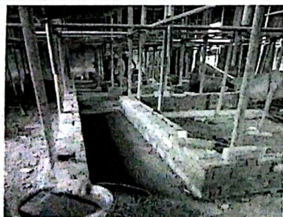
配电综合楼室内电缆沟砌筑
