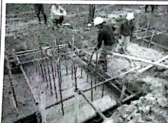
设备基础浇筑
