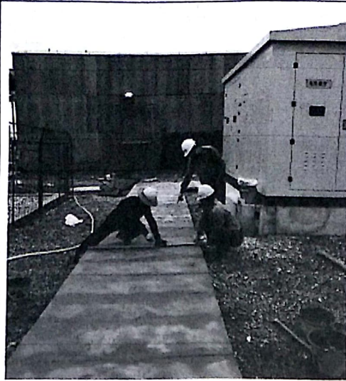
监理人员巡视检查
