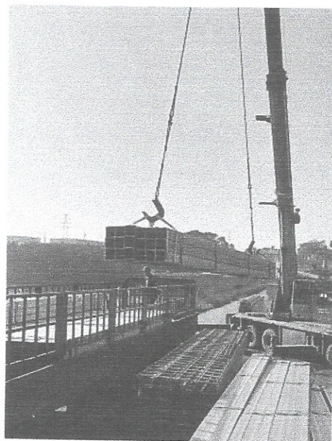
横梁材料进场吊装
