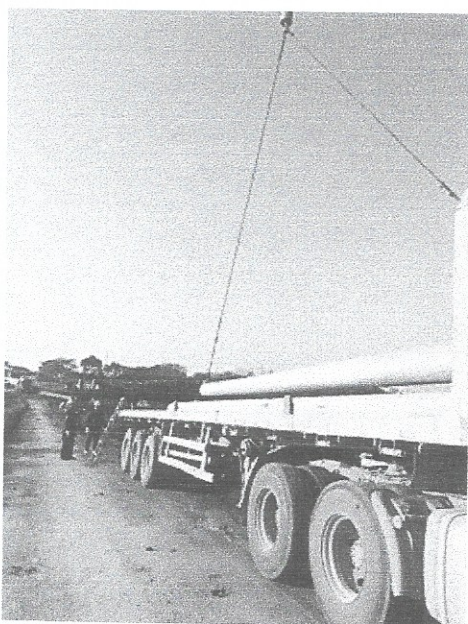
管桩进场吊装
