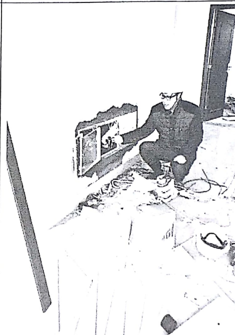
办公楼网线箱安装检查
