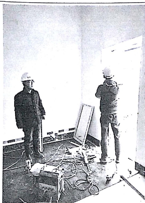
监理人员巡视检查
