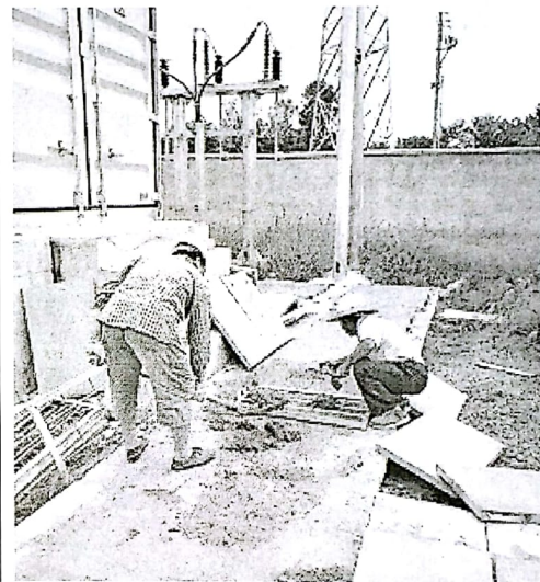
电缆沟盖板预制施工
