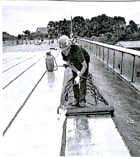
办公楼屋面防水施工
