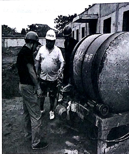
监理人员安全检查
