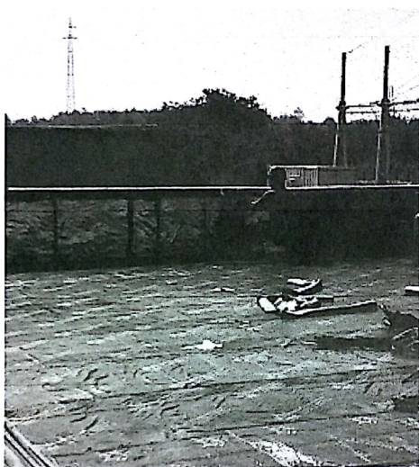
办公楼屋面防水施工
