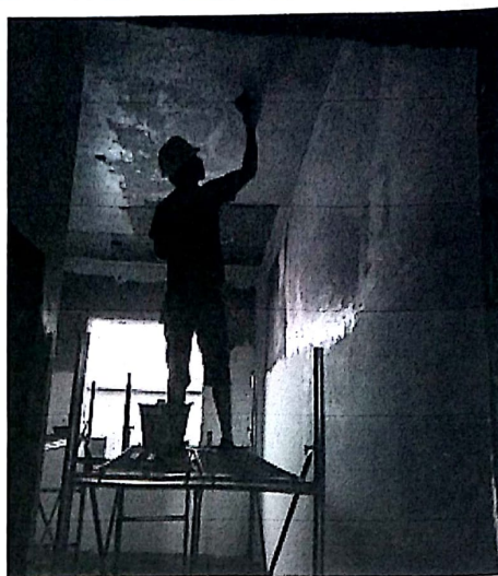
办公楼室内涂料粉刷施工
