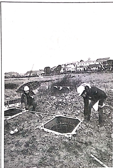
监理人员外线施工情况检查
