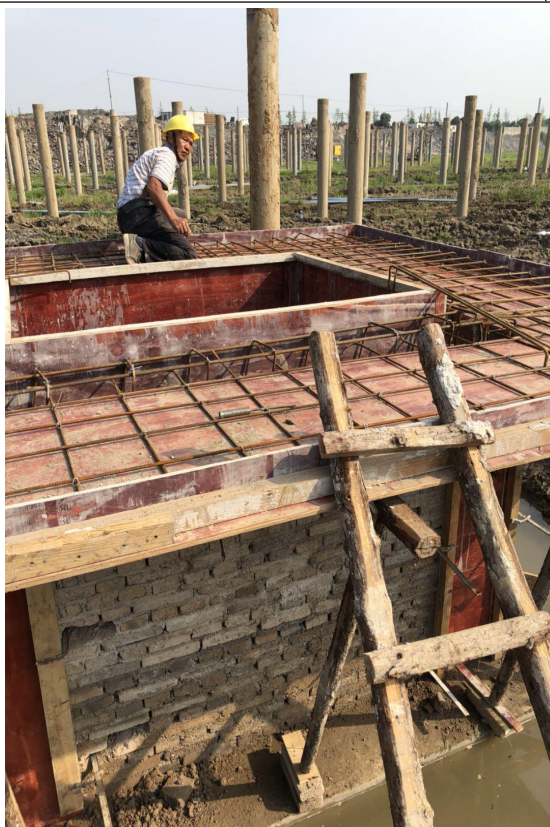
光伏区 6#箱变钢筋绑扎
