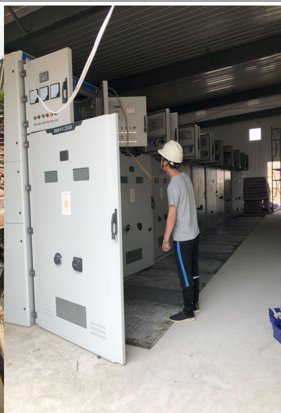
升压站中控楼设备检查
