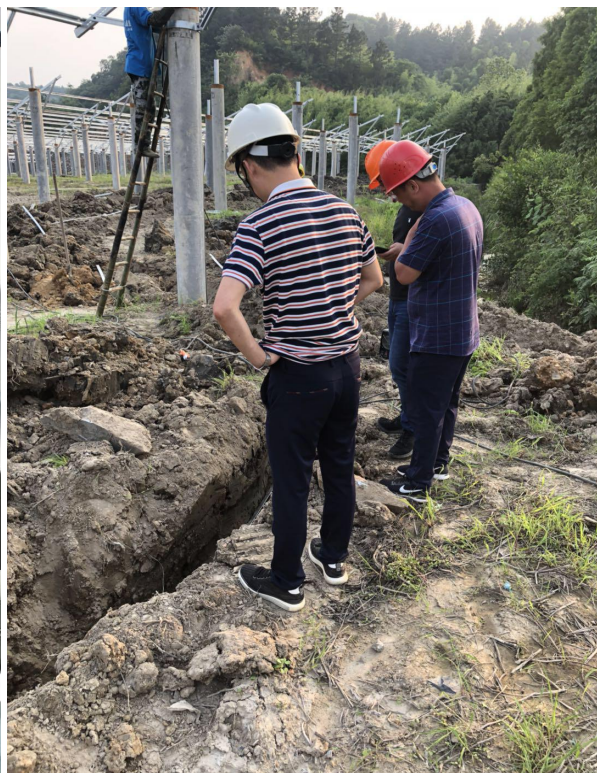
光伏区接地扁铁搭接
