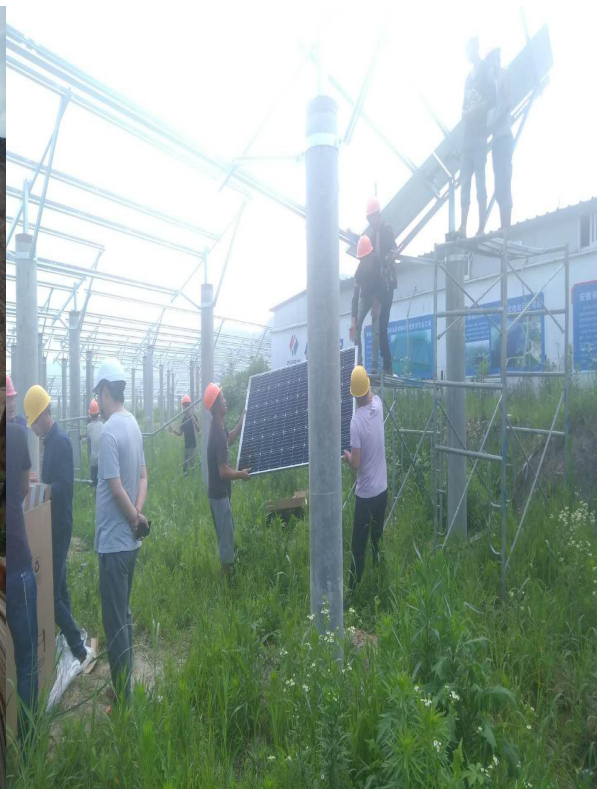
光伏区组件安装
