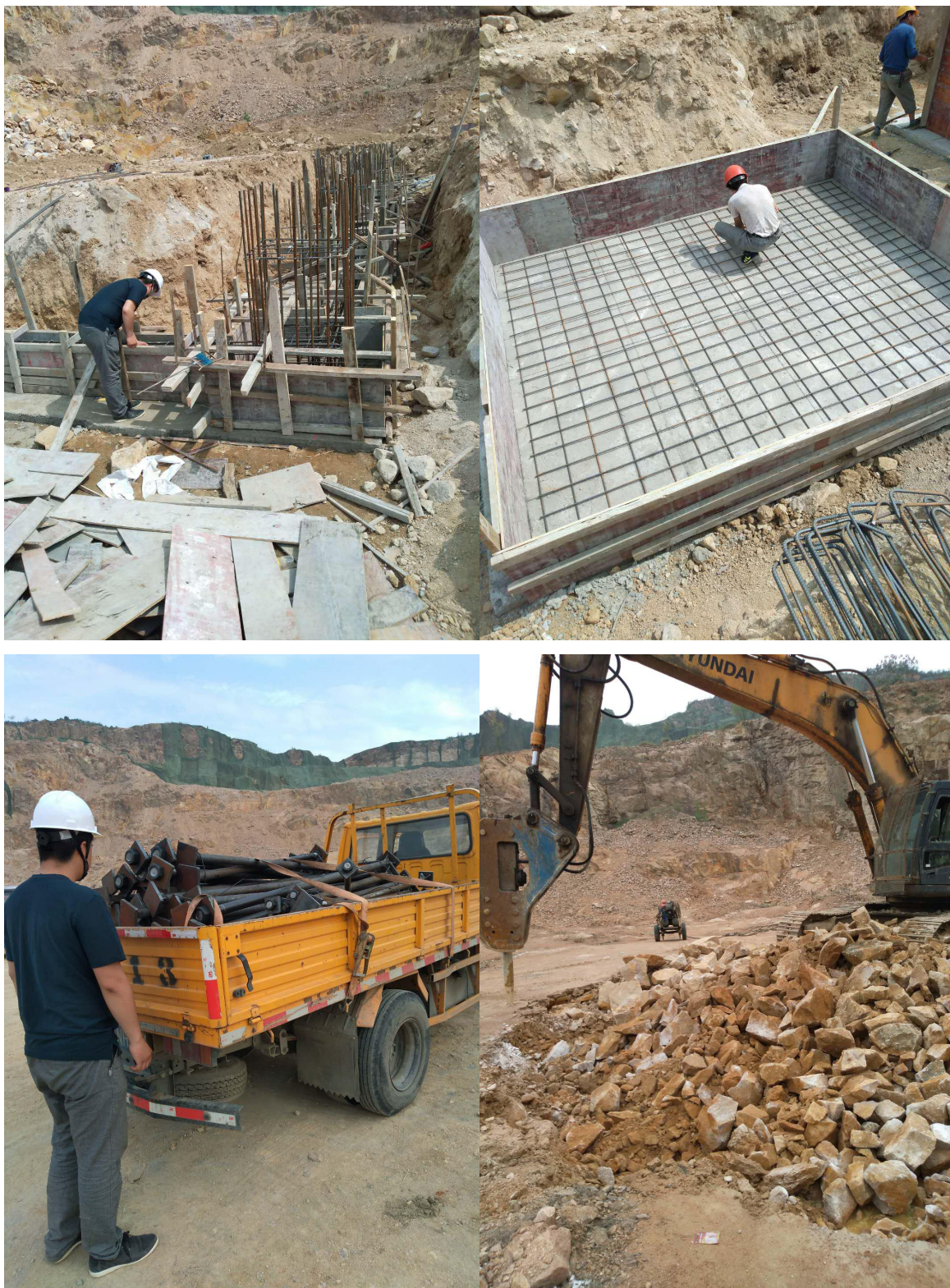
升压站钢筋绑扎及线路基础开挖和线路预埋螺栓到位
