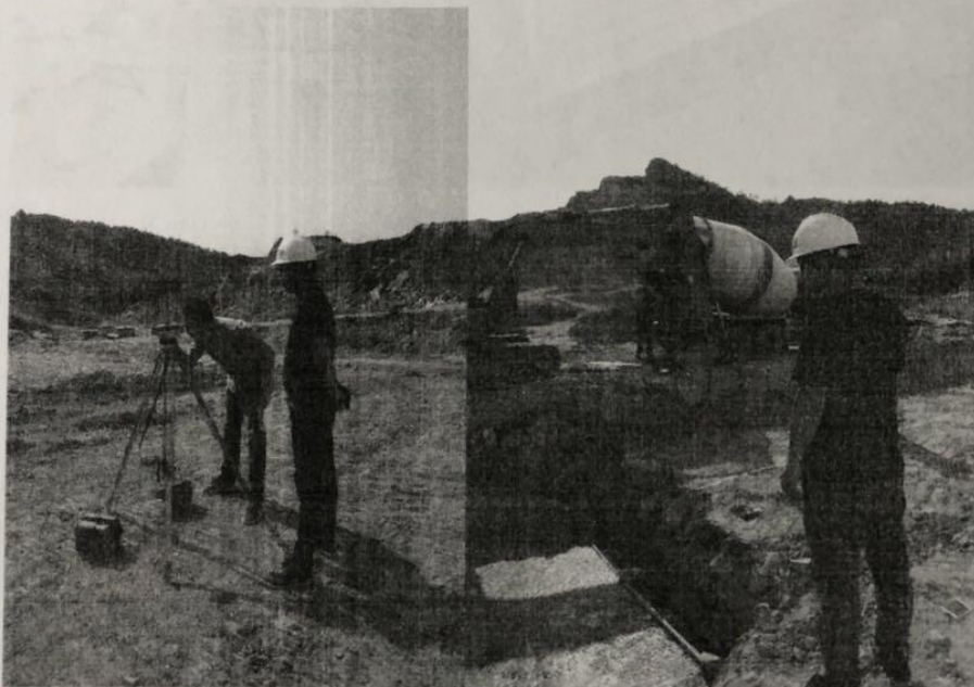
升压站定位及基础垫层浇注
