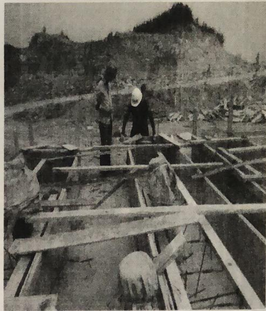
升压站接地变基础检查
