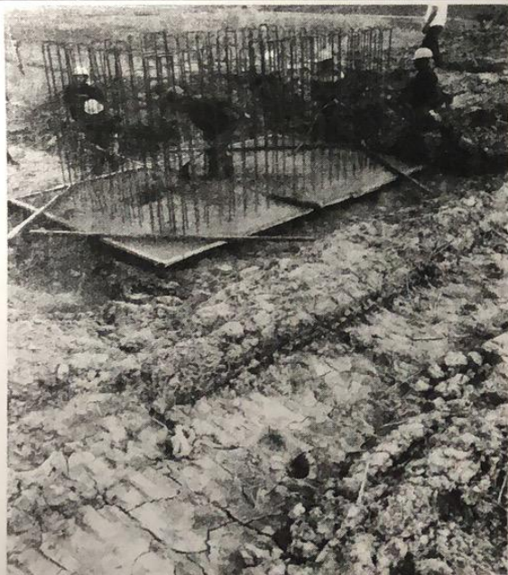
光伏区箱逆变基础浇筑
