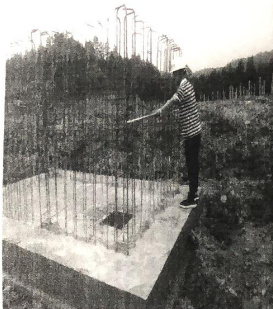
光伏区箱逆变基础钢筋检查
