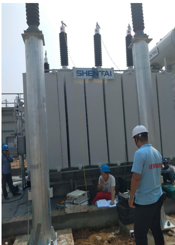
升压站设备调试
