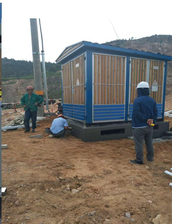
升压站 10KV 变压器安装
