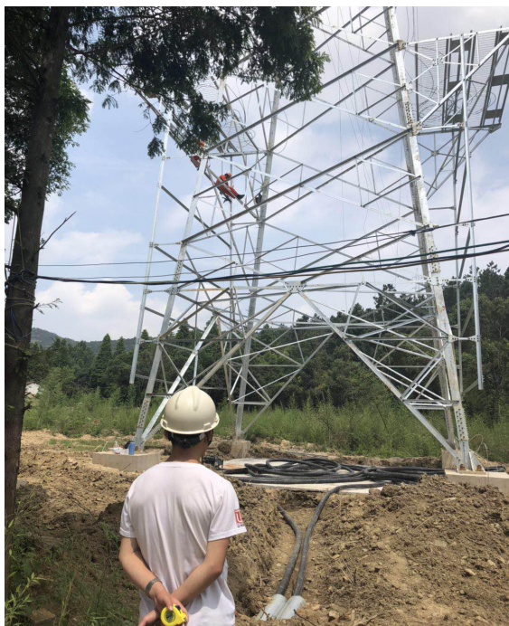
线路电缆拉接
