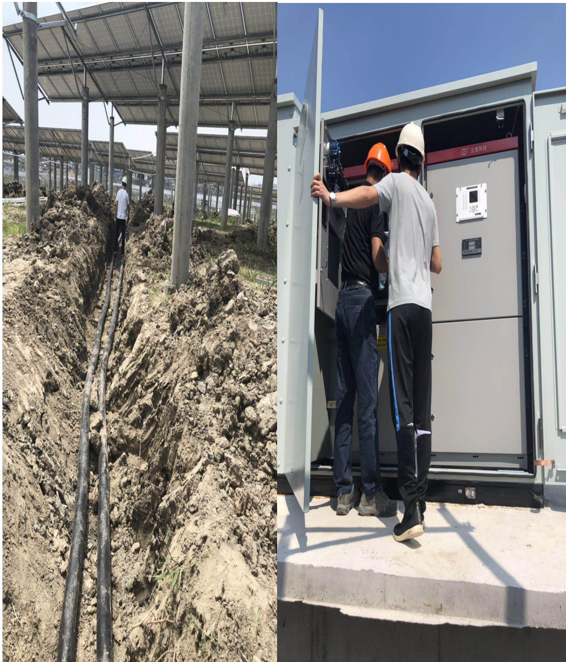
光伏区电缆敷设
