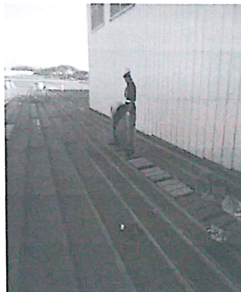
屋面临时走道板铺设
