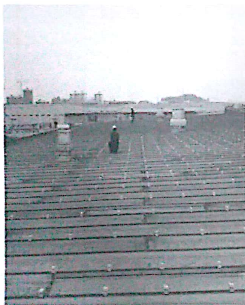
屋面夹具安装
