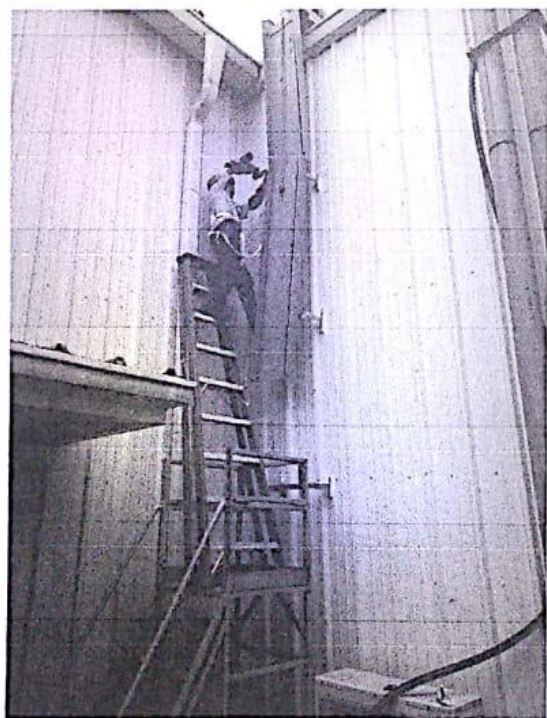
垂直桥架安装
