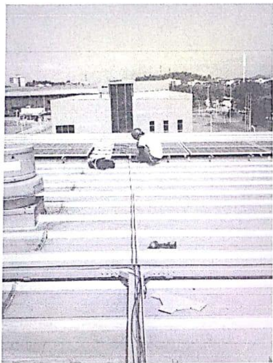
4 平方线缆穿管
