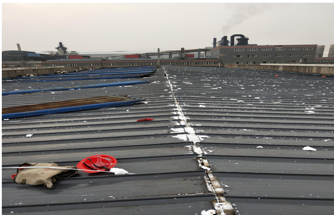
5 号厂房屋面换瓦完成
