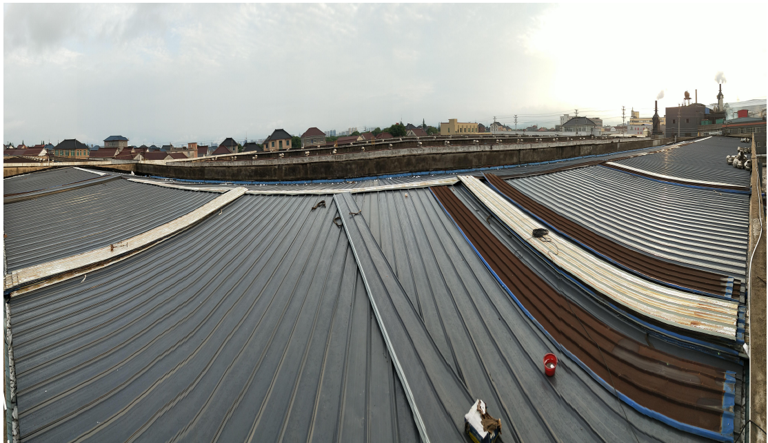
8 号厂房屋面换瓦完成
