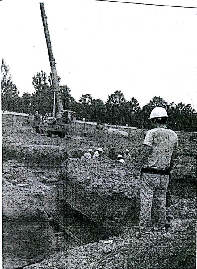
主控楼混凝土基础浇筑
