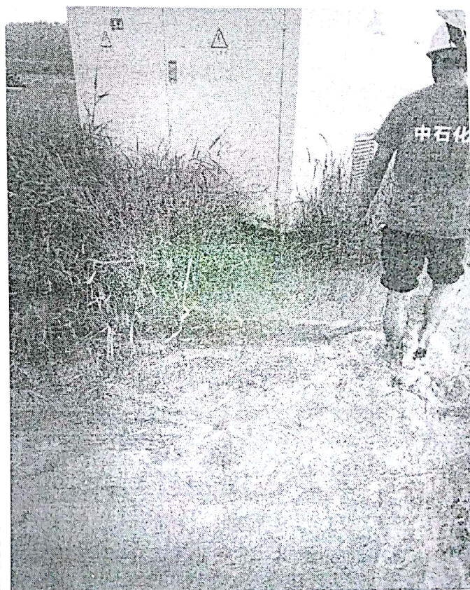
查看雨水浸泡设备情况
