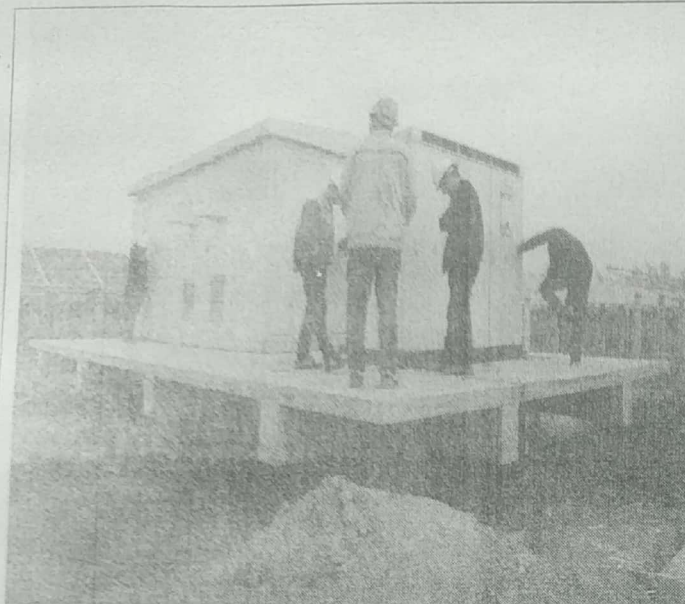
S39 箱逆变送电前检查
