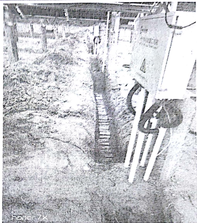
41 区直流电缆沟验收
