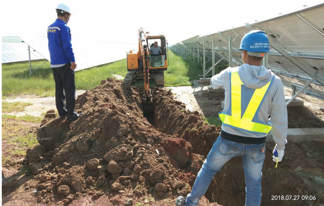
监理检查新增光伏组串接地主网开挖
