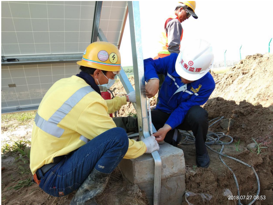
监理检查新增光伏组串接地主网镀锌扁铁搭接
