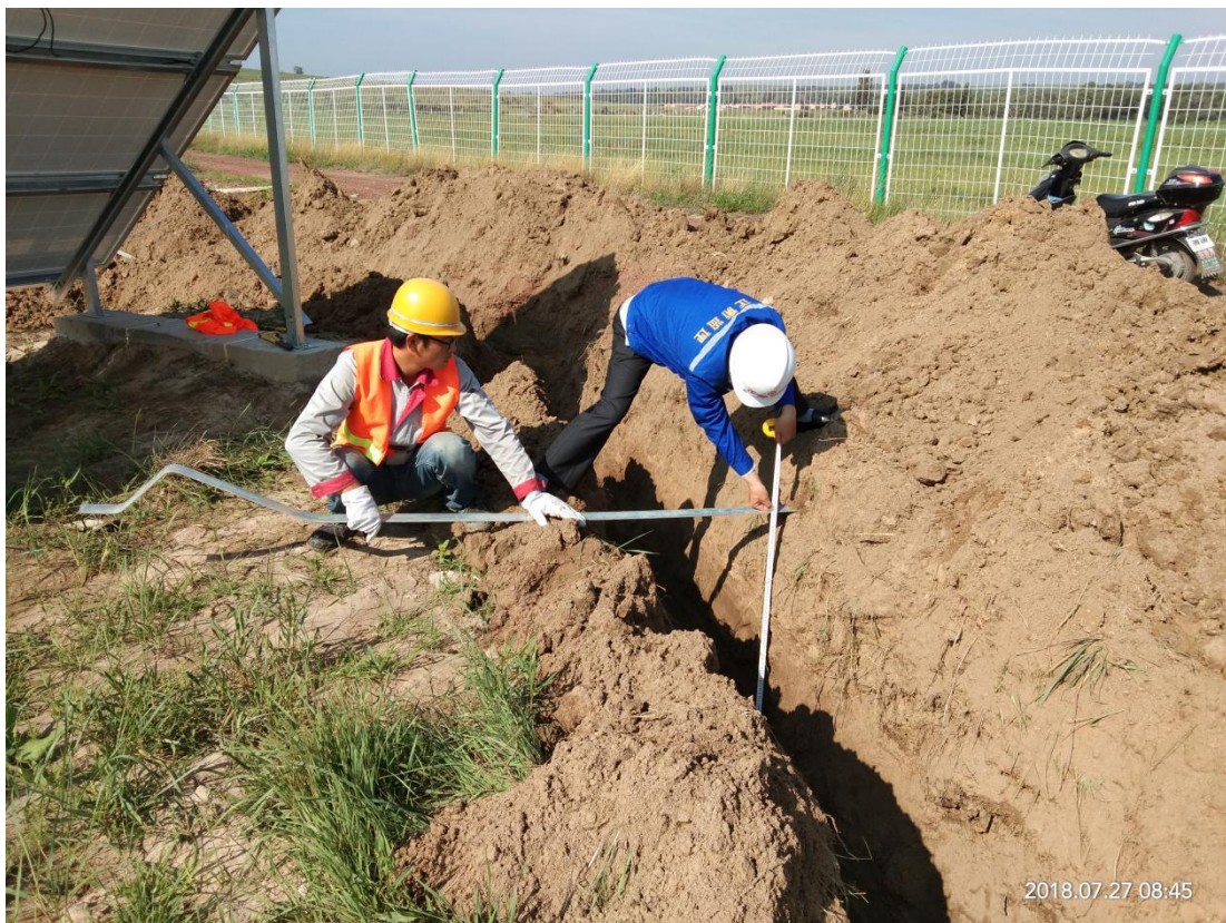
监理检查新增光伏组串接地主网沟开挖深度
