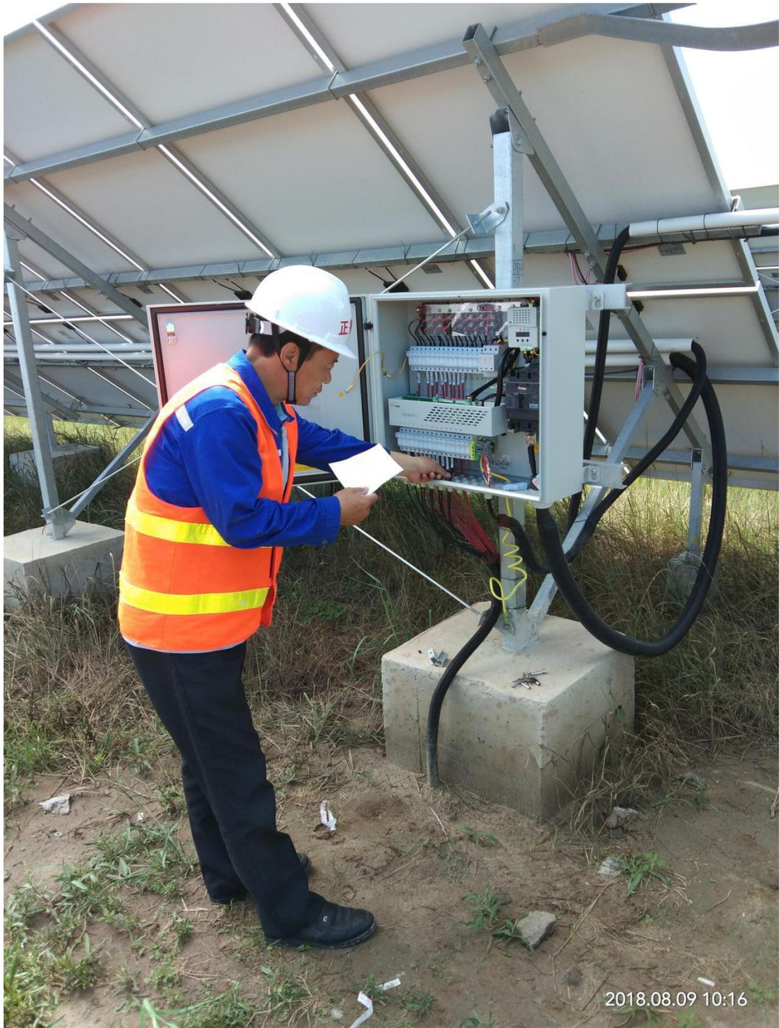
监理检查新增汇流箱组串号码管及防火封堵
