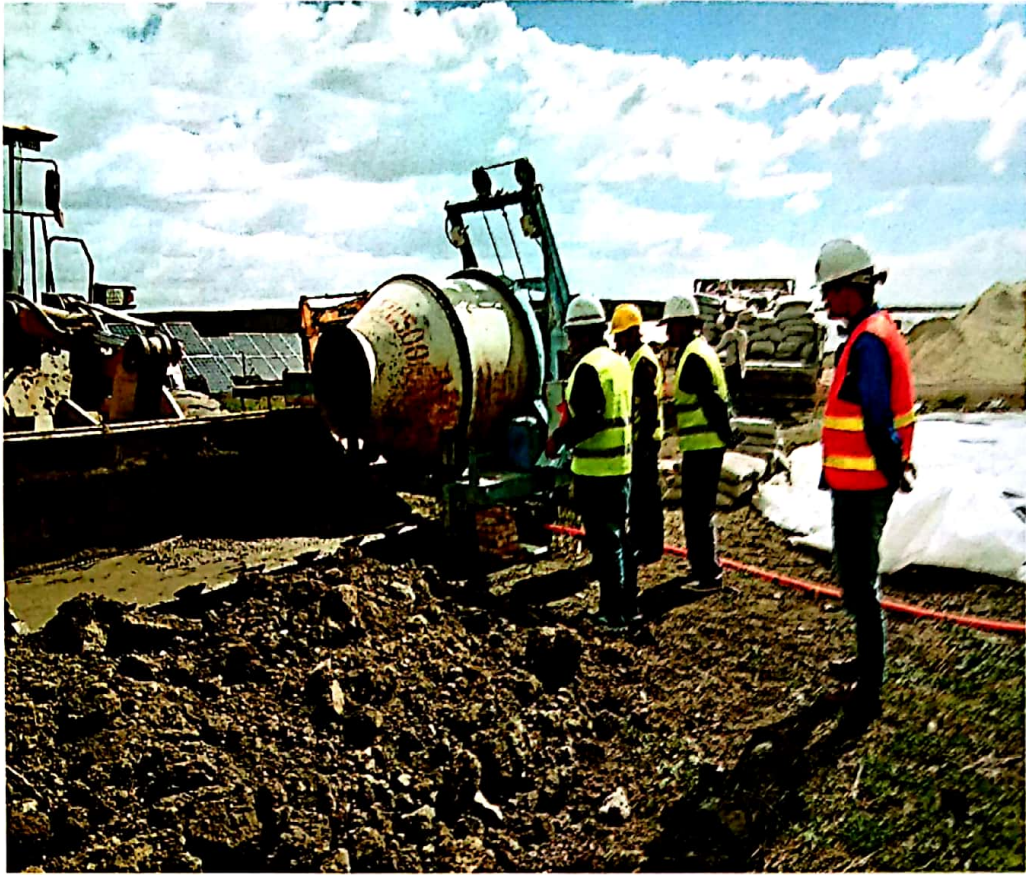
监理现场检查混凝土搅拌
