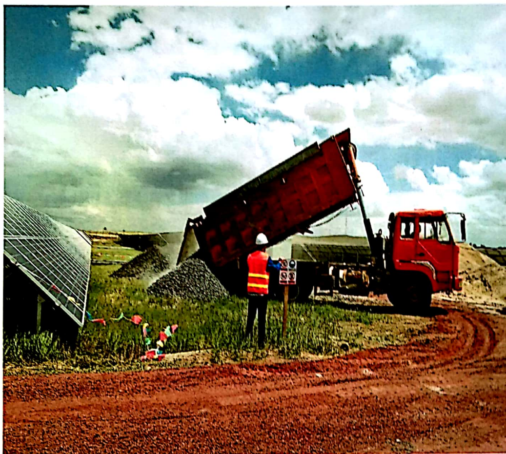
监理现场检查验收材料进场
