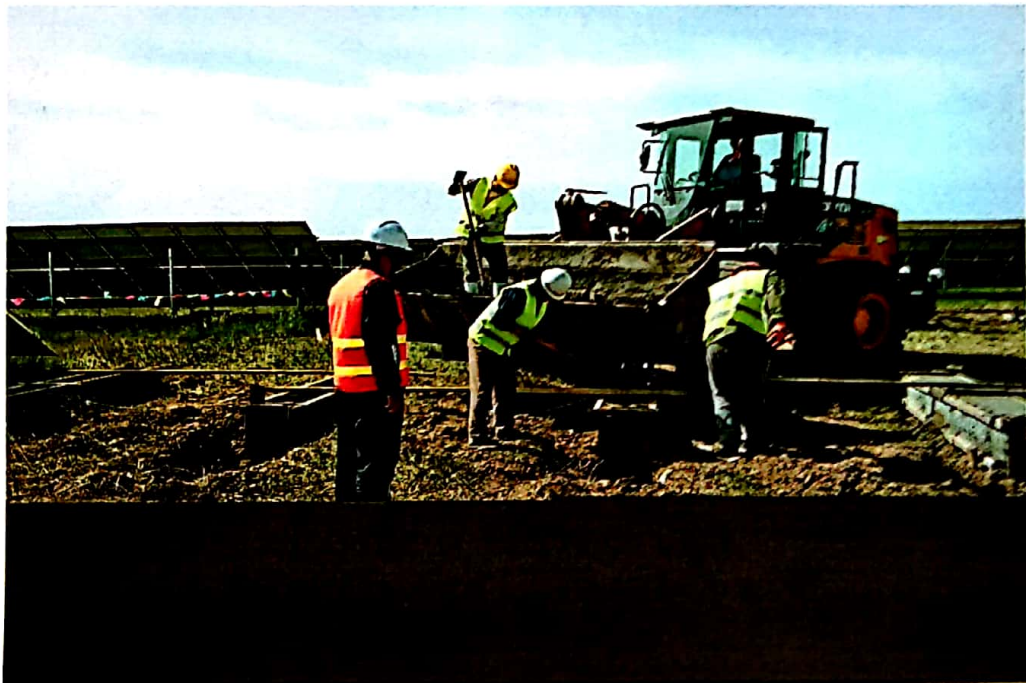
光伏支架基础浇注监理旁站
