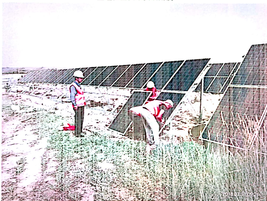
监理检查组件安装
