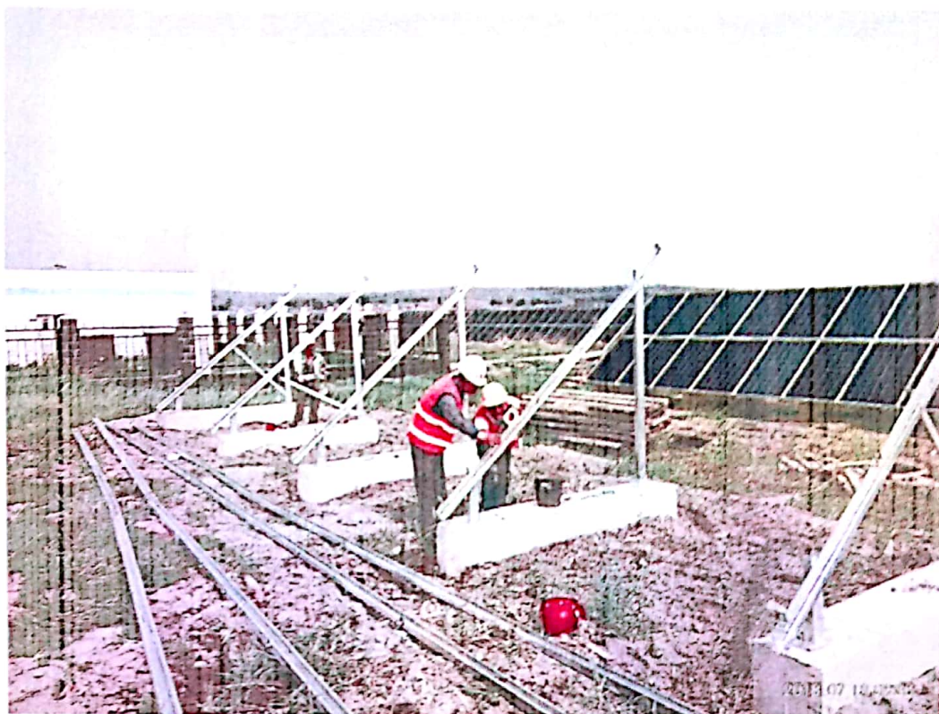
监理检查支架安装角度
