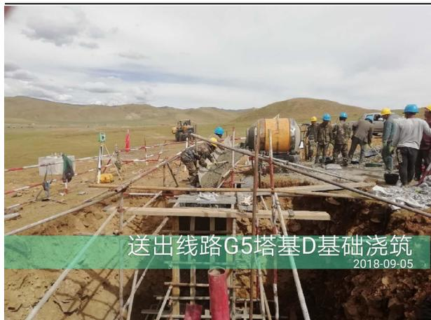
送出线路G5塔基D基础浇筑
