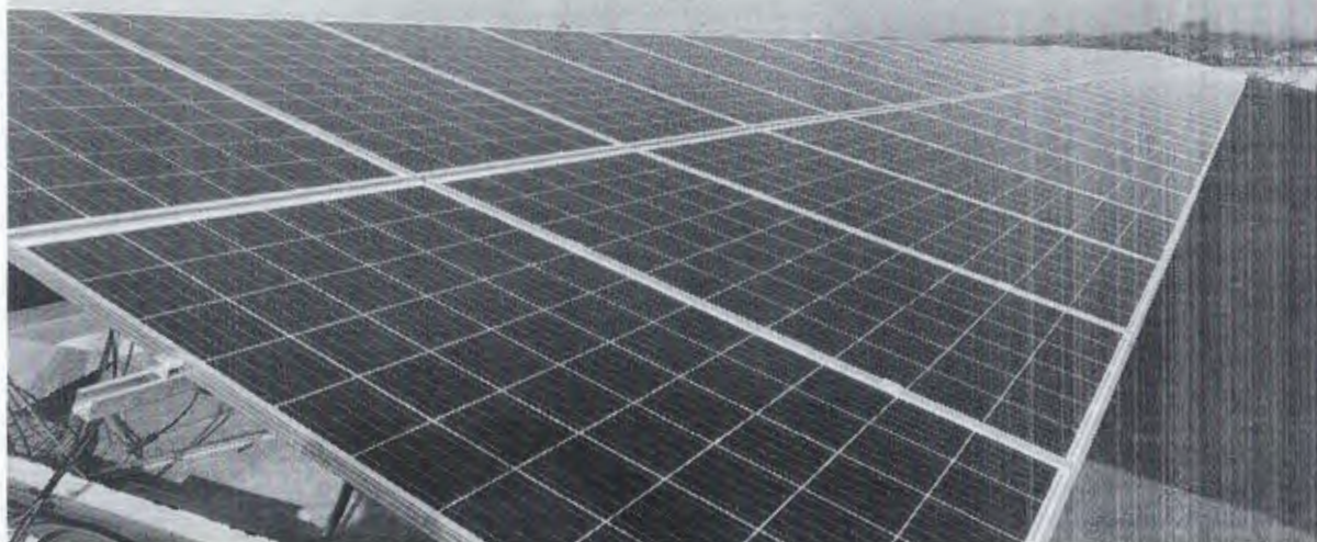
瑞金市“十二五”贫困村光伏扶贫扩面工程 江雄管道厂房屋顶电缆敷设20180929
