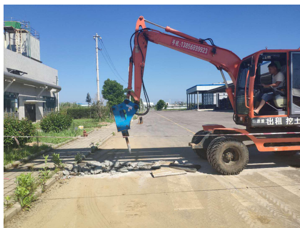
碎石机对路面进行施工
