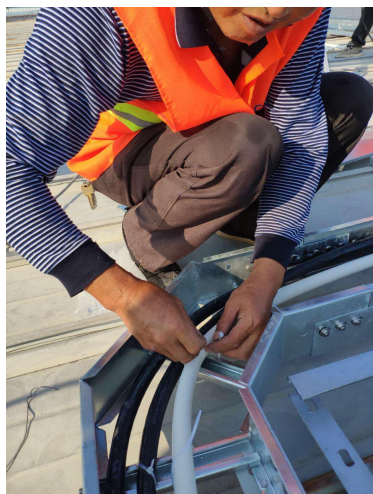
绑扎通信电缆 PVC 管
