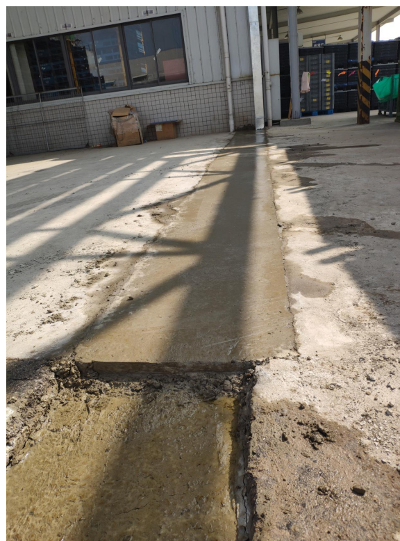
路面回填浇筑
