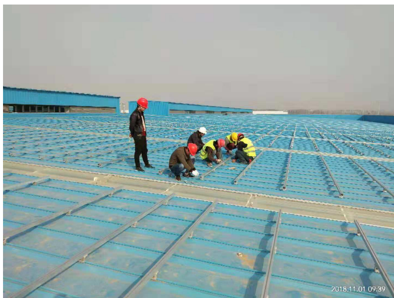
D 号厂房檩条安装
