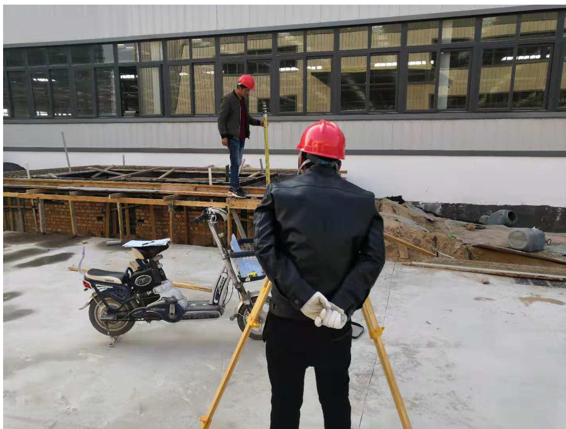
箱变基础标高复测
