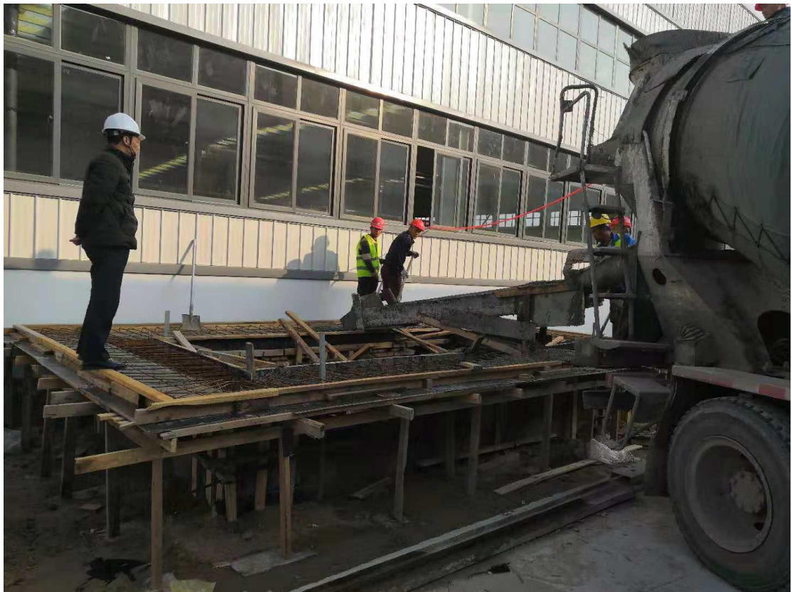
箱变基础浇筑
