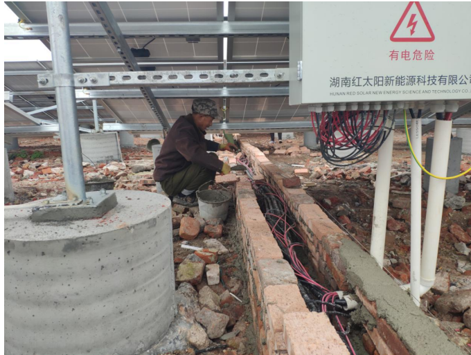
机械区砌筑电缆沟
