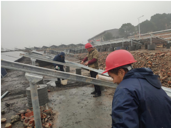
机械区安装支架
