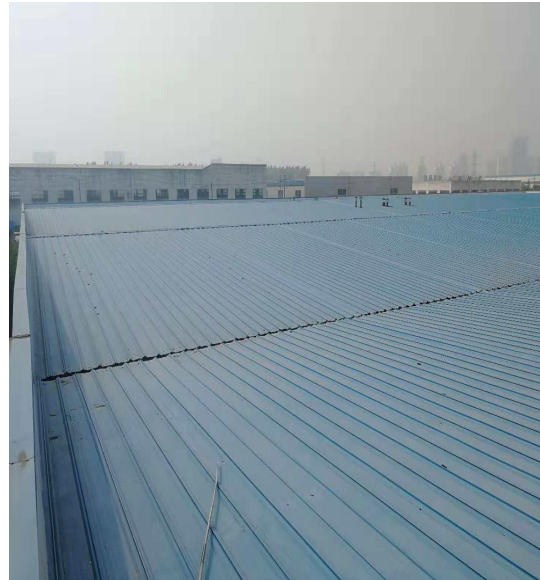
厂房屋顶原貌
