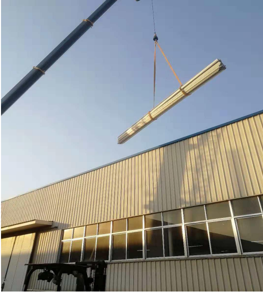
屋顶导轨吊装
