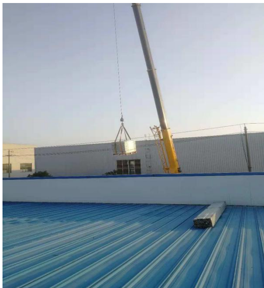
屋顶导轨吊装
