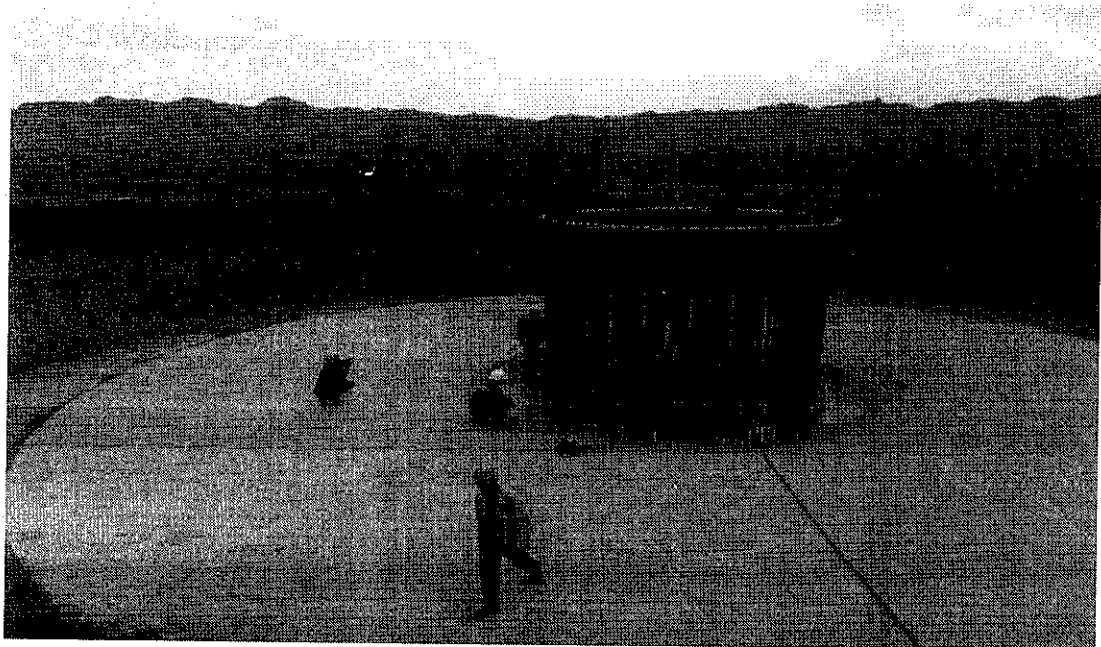
临边防护不到位
