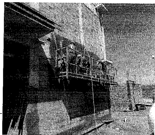
外墙吊篮施工未经过验收
