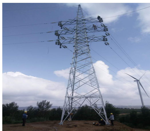
铁塔导线施工
