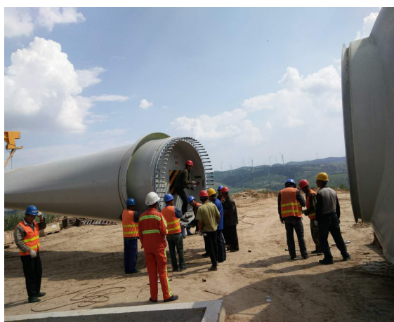
K03 号机位叶片组装
