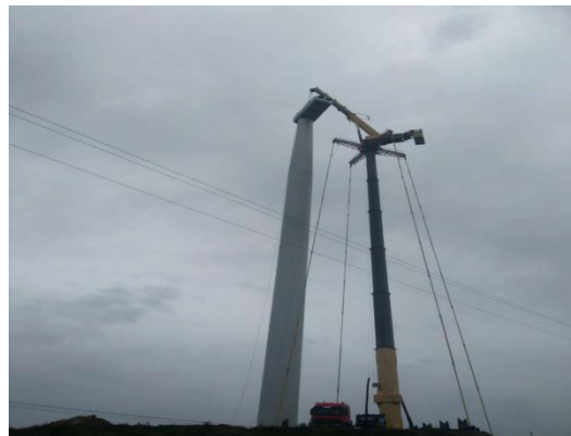
B08 号机位机舱吊装
