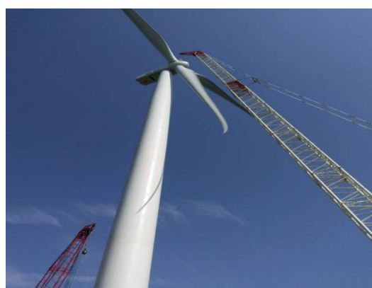
K03 号机位叶片吊装完成
