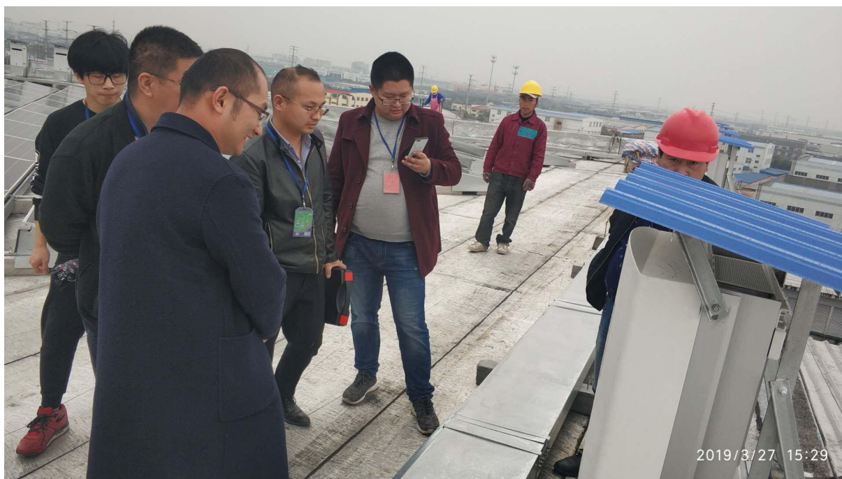
并网柜防火封堵整改完成
