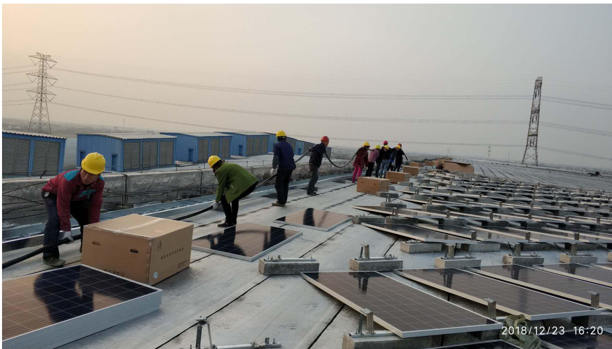
电缆吊运、展放
