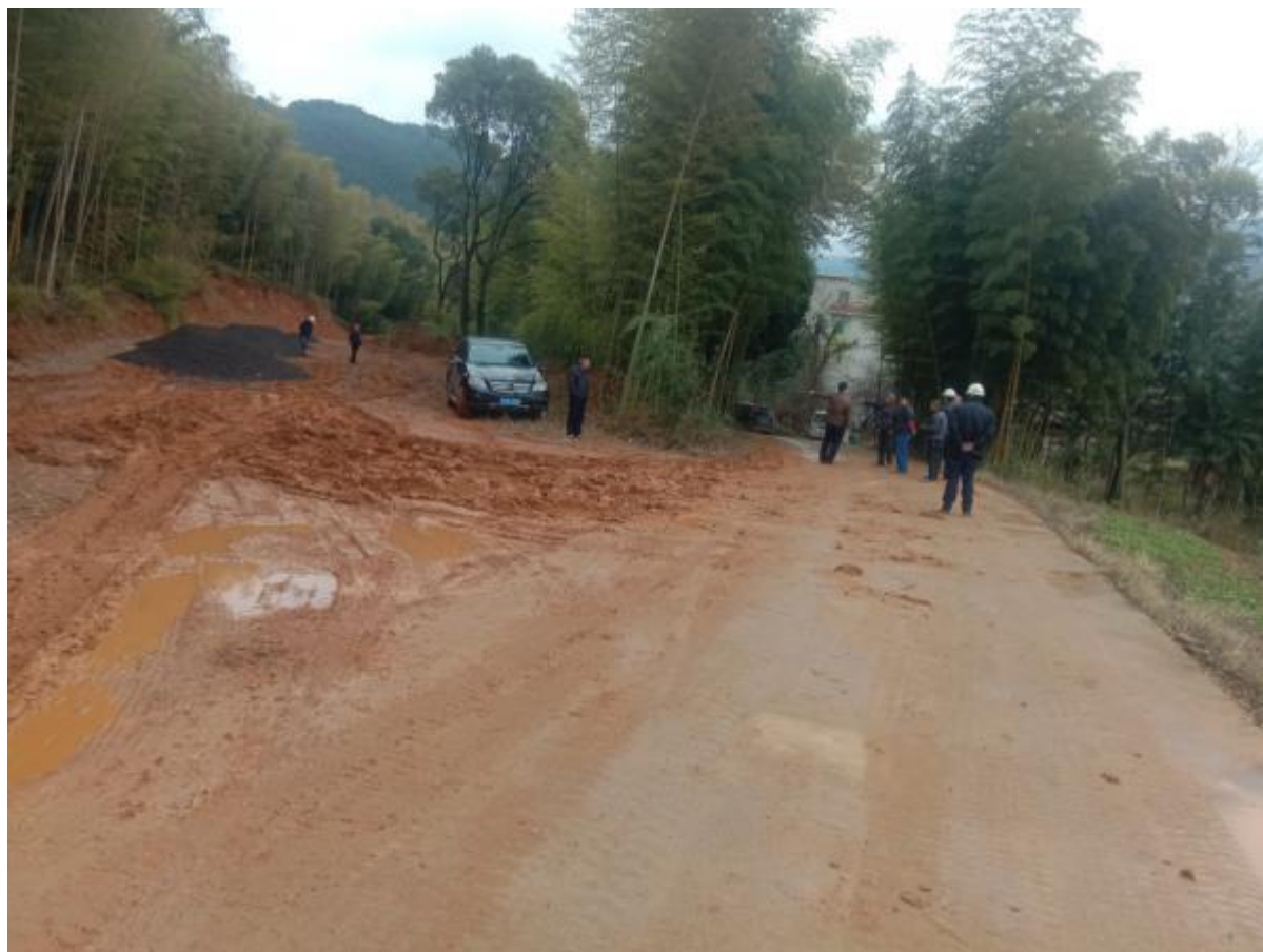
2019.12.26 敷设瓜山村与进场道路交叉的路段
