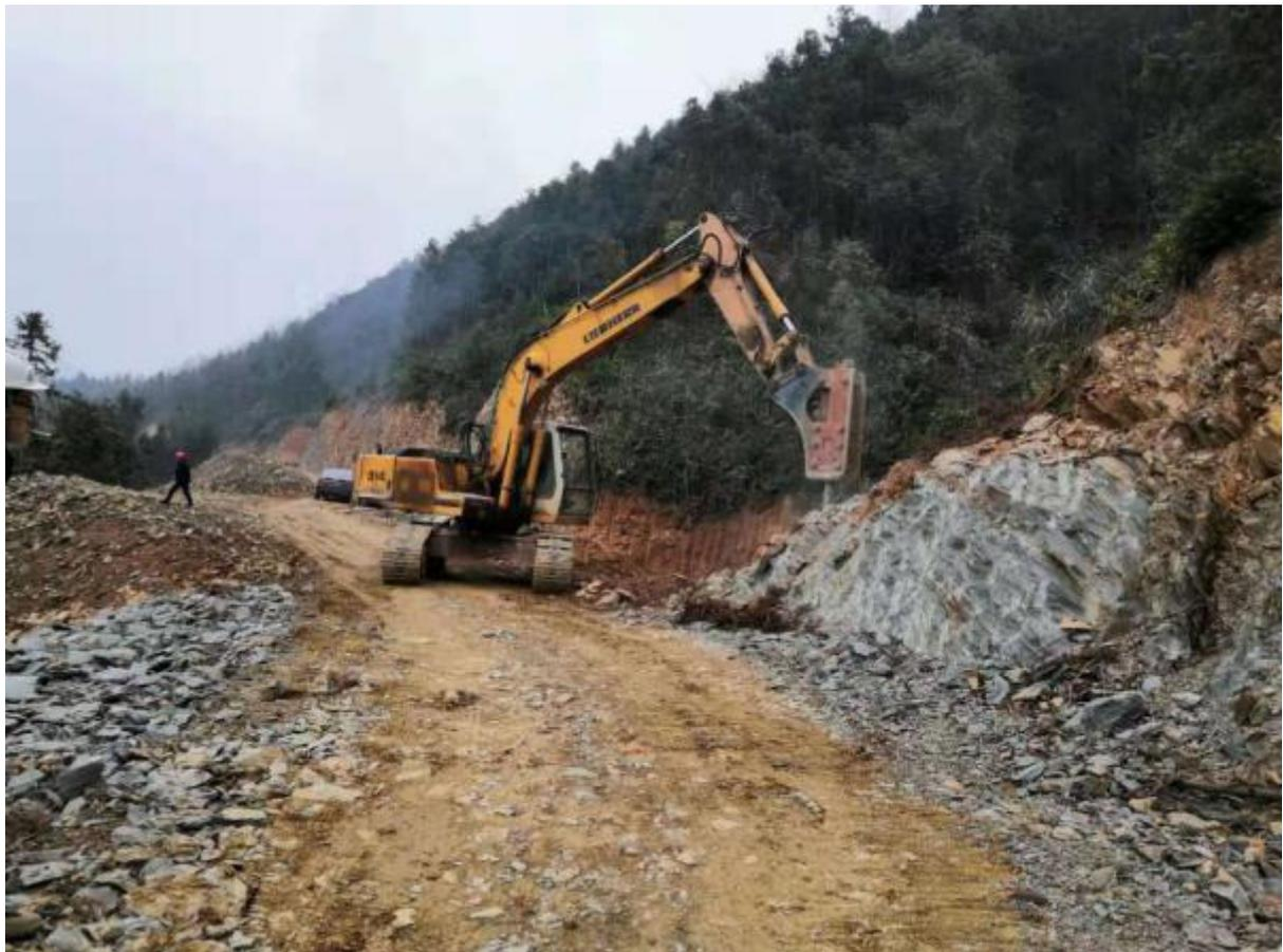
2020年01月03日下午四时进场道路排水沟内的岩石较硬，凿岩机无法完成
