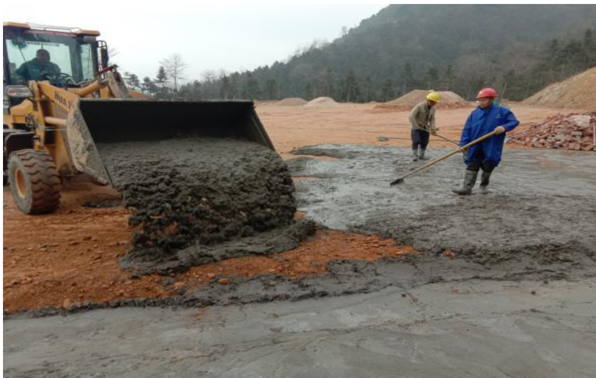
2020. 1. 9 钢筋棚地面浇筑
