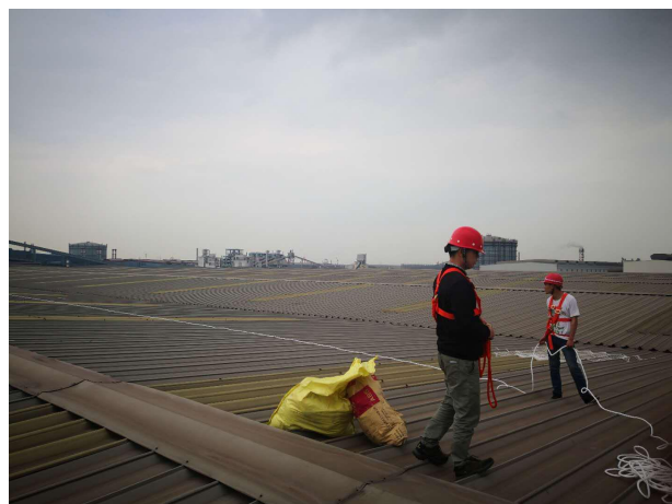
海力物流屋面进行安全措施施工
