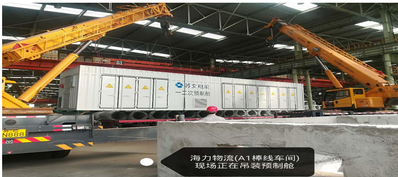
西区吊装箱变预制舱
