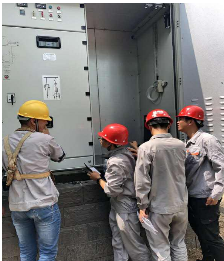
箱变发电功率测试
