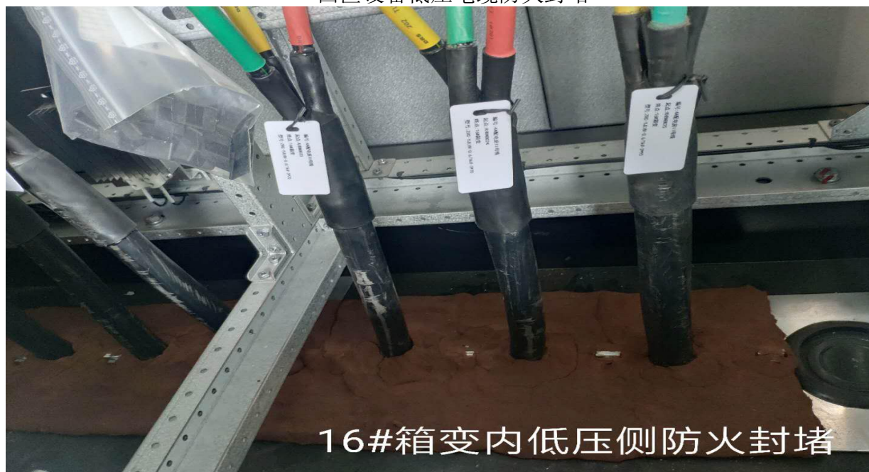
西区设备低压电缆防火封堵
